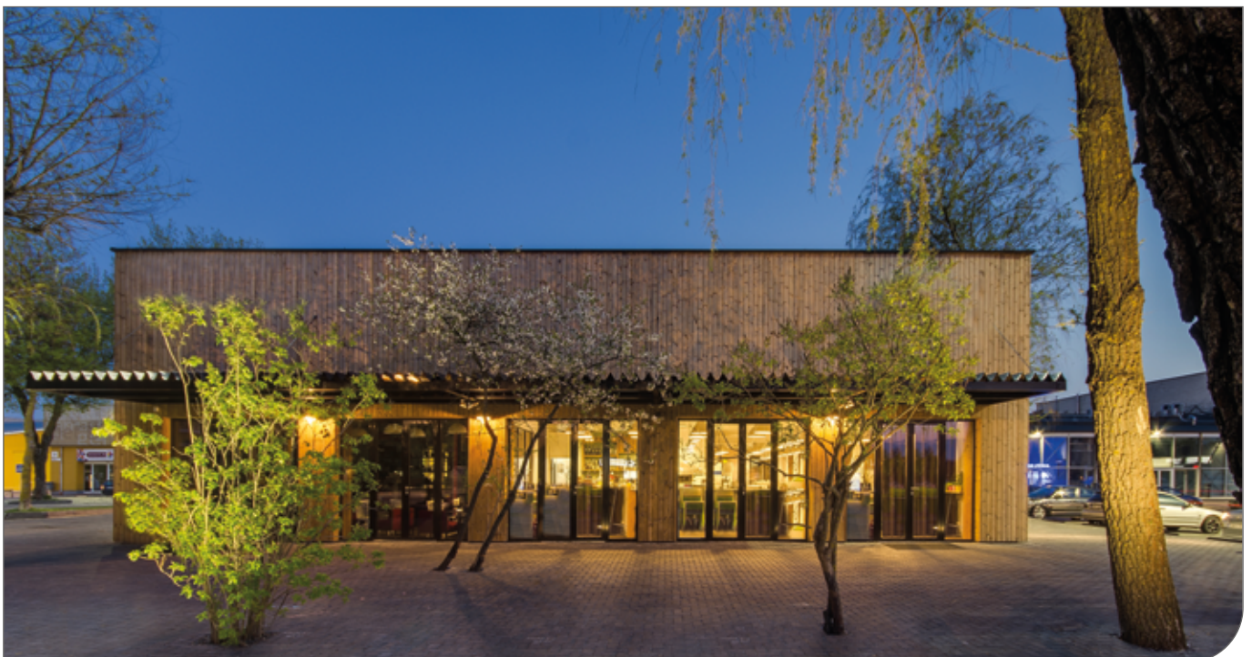
Kuva 59. ThermoWood®-ulkooverhous ravintolan seinässä (Liettua).
