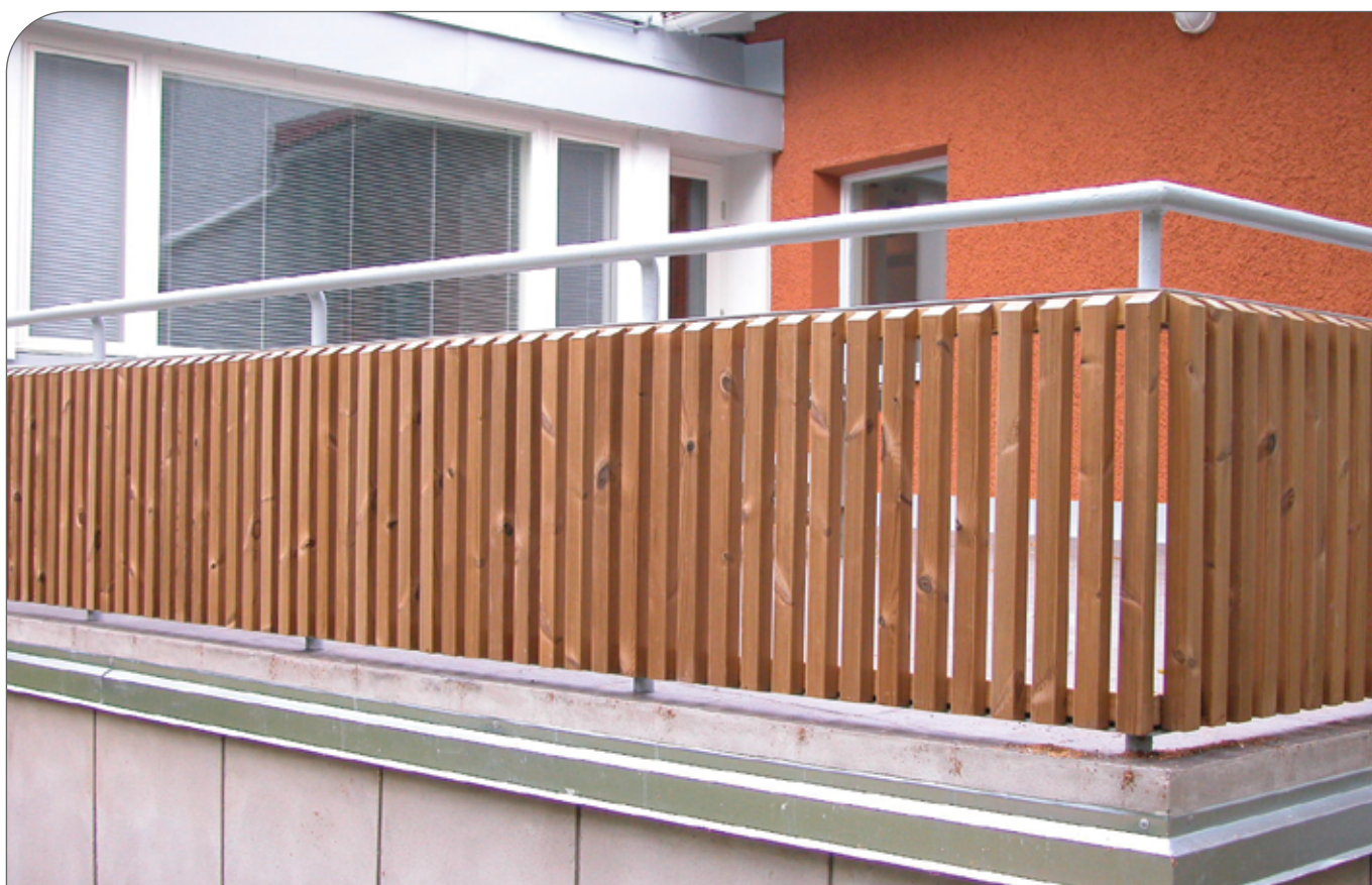
Kuva 66. ThermoWood®-rimoitus parvekkeen kaitteessa.
